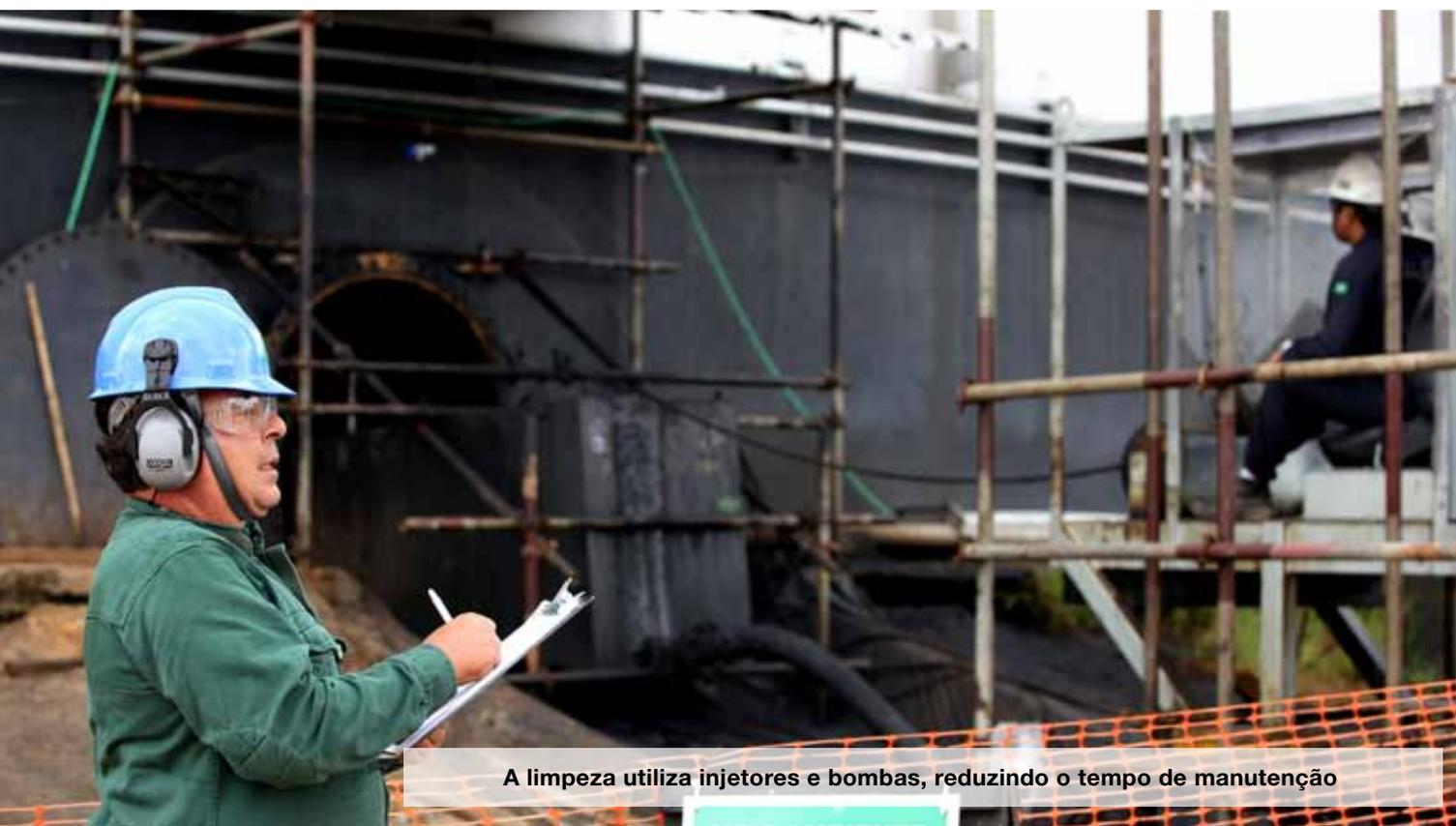
A limpeza utiliza injetores e bombas, reduzindo o tempo de manutenção
